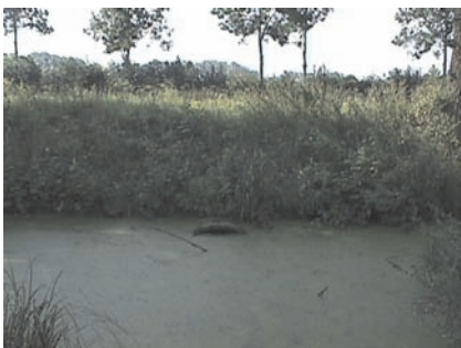
De duiker (nr. 06) die door de dijk loopt tussen het Capreton en de visvijvers, die afgedicht dient te worden.
